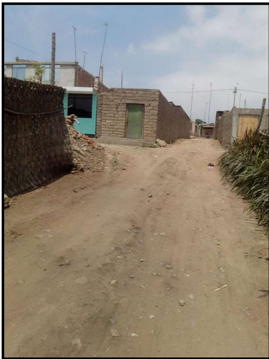
FOTO N° 04 – Podemos Observar la calle donde se proyectara la red de Agua y Alcantarillado.
