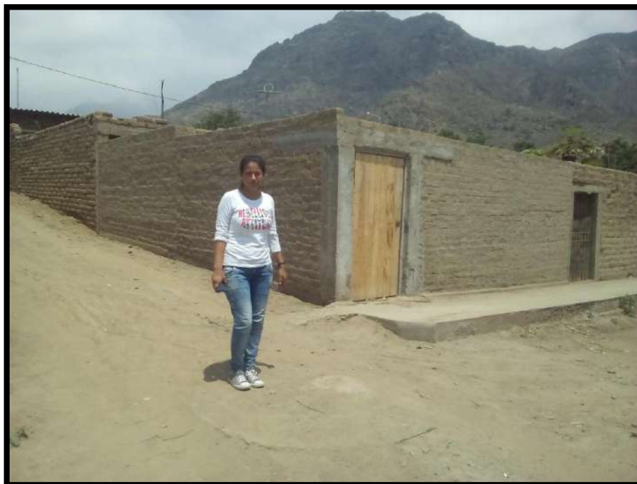
FOTO N° 05 – Podemos Observar la intercesión de las calles, donde además se encuentra ubicado el Buzón Existente.
