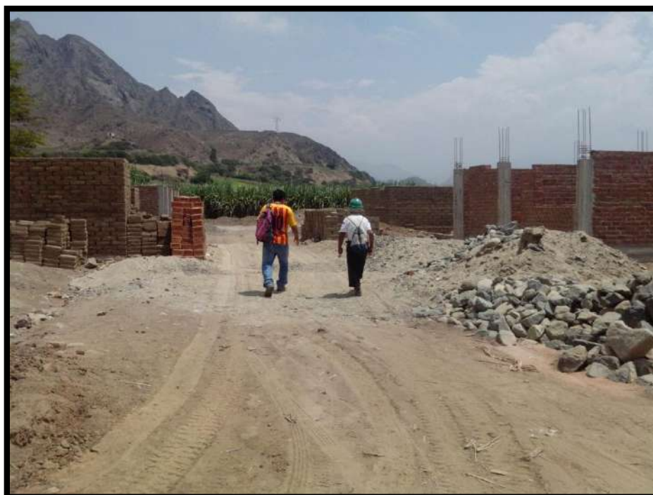
FOTO N° 07 – Se observa a un Poblador de la Zona indicándonos las calles donde se va a proyectar los sistemas de Agua y Alcantarillado.
