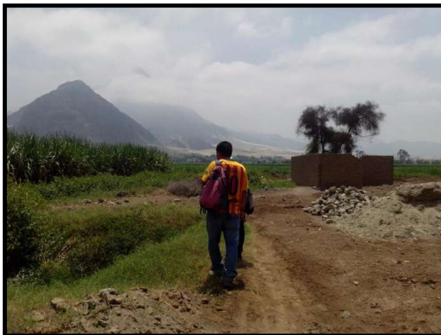
FOTO N° 11 – En esta imagen se ve dónde está el sistema de tratamiento de las Aguas Servidas de la zona. Lado Izquierdo.
