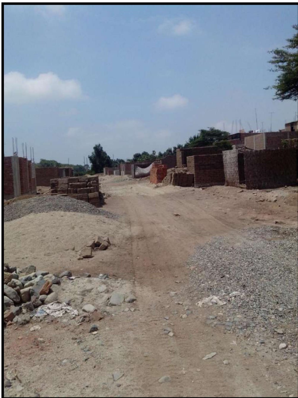
FOTO N° 09 – En esta imagen se puede ver más claramente la urgente necesidad de Agua y Alcantarillado para las nuevas construcciones que ya están construidas y las que se están dando.
