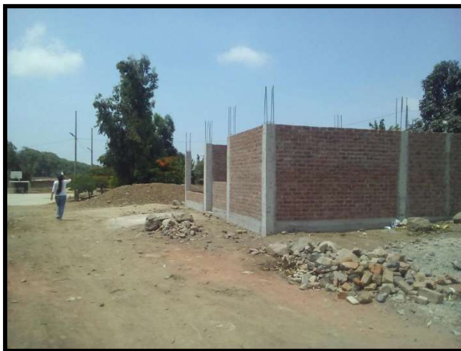
FOTO N° 10 – En esta imagen se ve el final de las calles a intervenir.
