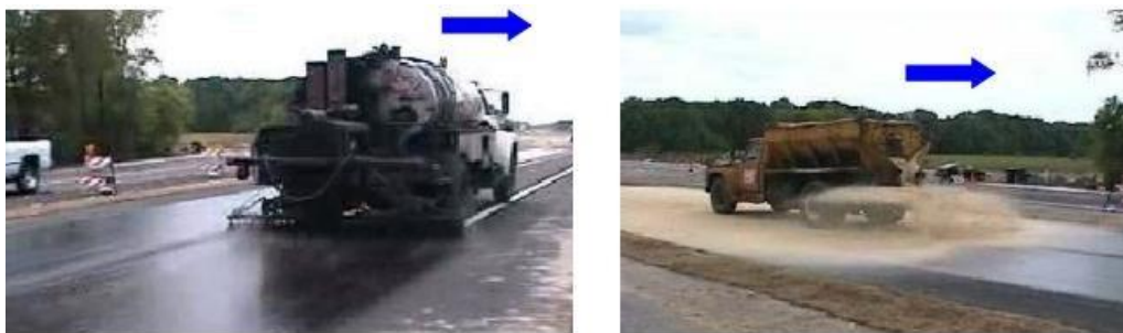
Figura 10: Sello arena sello arena – asfalto
