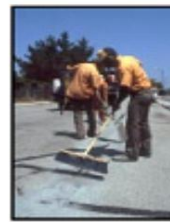
Aplicación de arena
