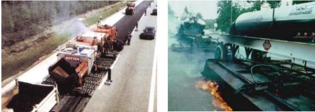
Figura 09: Reciclado superficial en sitio y en caliente
