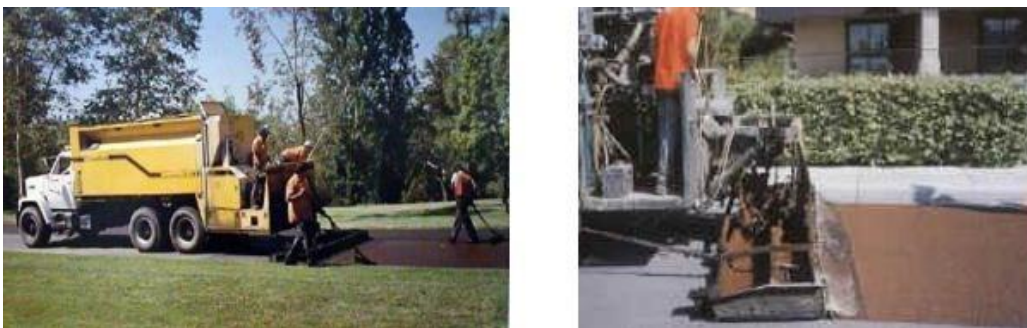
Figura 05: Aplicación de lechada asfáltica y micro-aglomerado en frío
