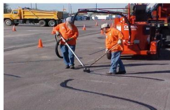
Sellado de la grieta
