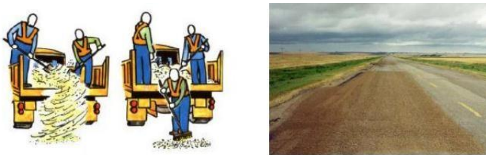
Figura 04: Procedimiento típico de arenado
