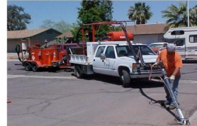
Limpieza de la grieta con aire comprimido
