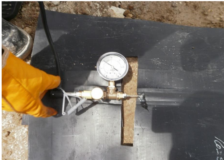
Figura 05 Prueba de aire test.
