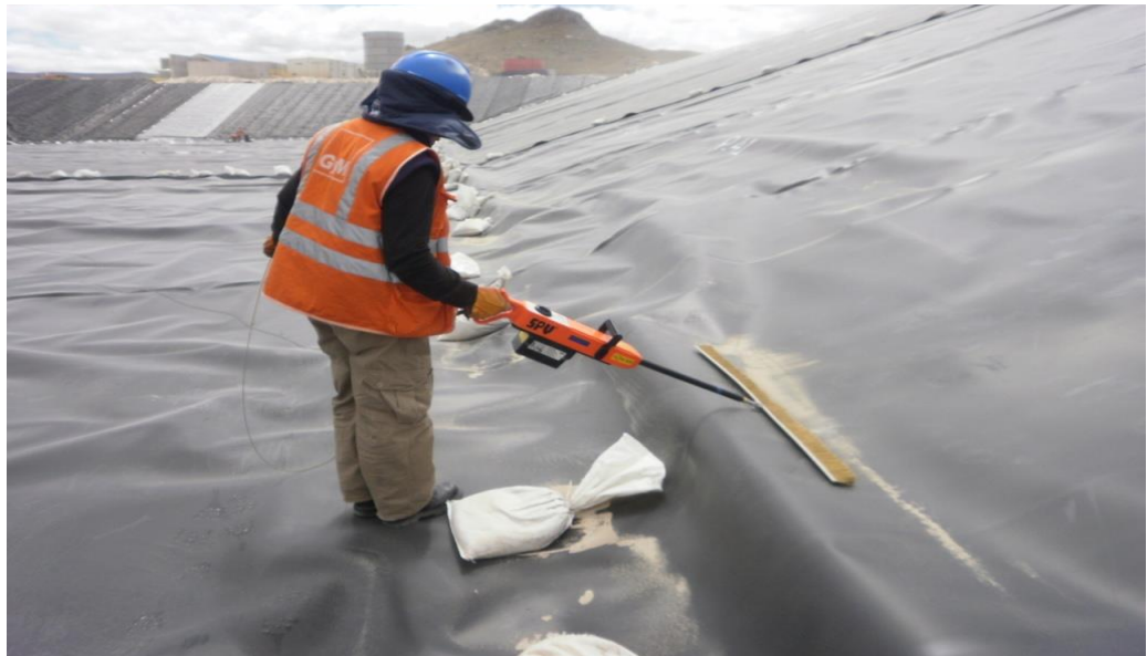
Figura 08. Prueba geo-eléctrica para la geomembrana
