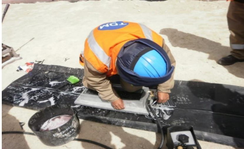
Figura 06 Prueba de vacío o “vacumm test”
