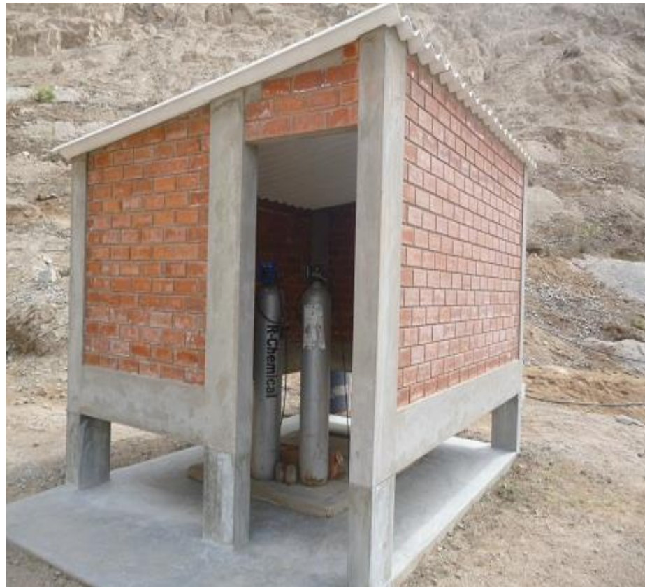
FIGURA N°11: CASETA DE CLORACION
