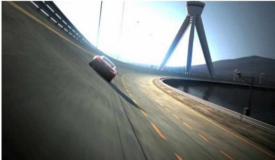
Figura N° 3: Curva peraltada que contrarresta la fuerza centrípeta
