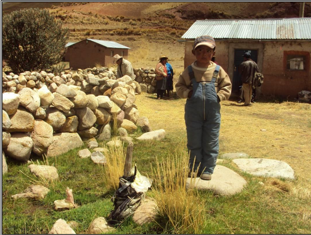
Foto N° 03.- Pileta domiciliaria en estado físico muy deteriorado, ubicada en la zona media de Caluyo. Se observa que el grifo está adosado a un madero.
