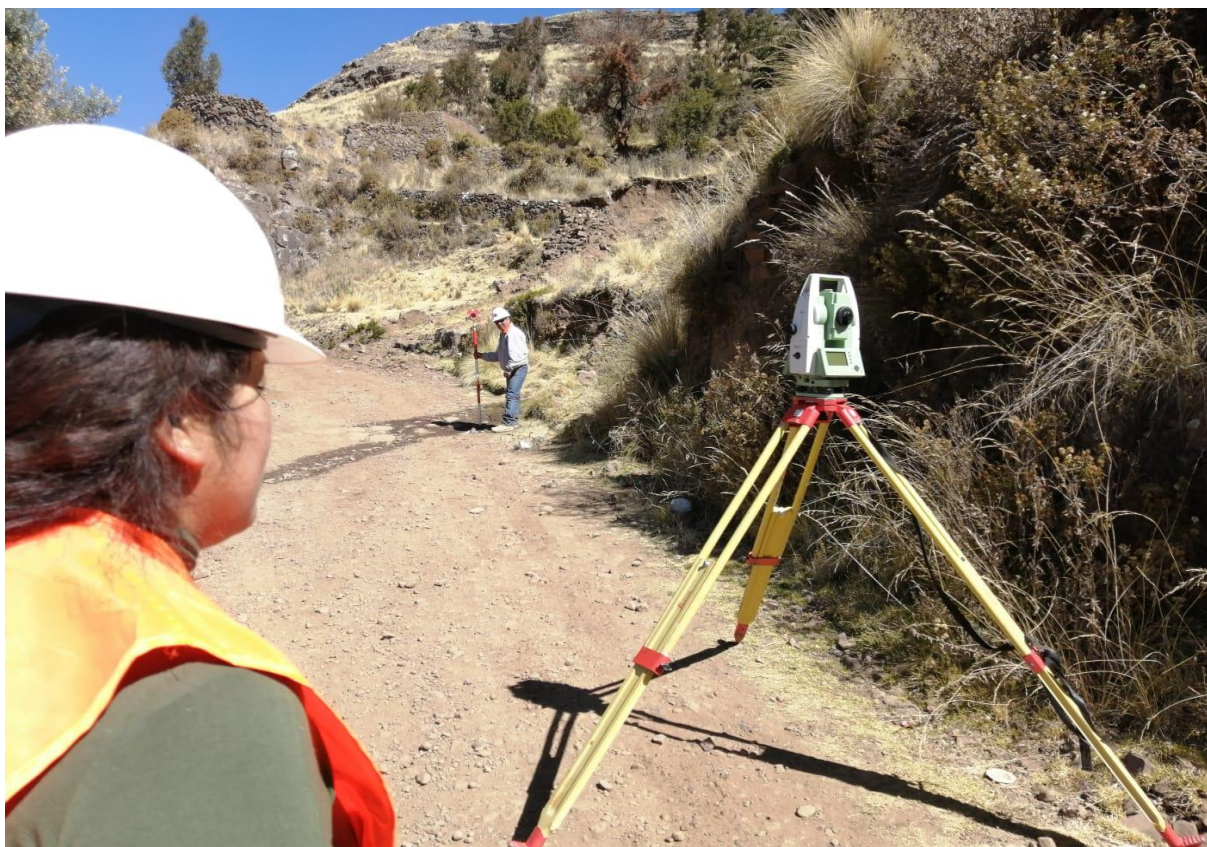
Foto A1. Levantamiento topográfico
