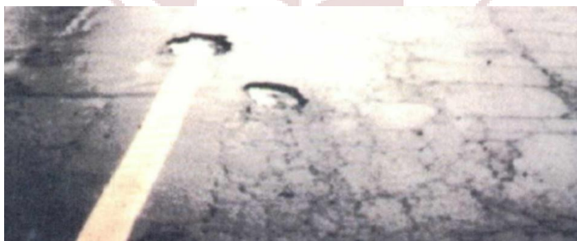
Figura 16: Huecos. Fuente: Ministerio de Transportes y Comunicaciones. (2014)
