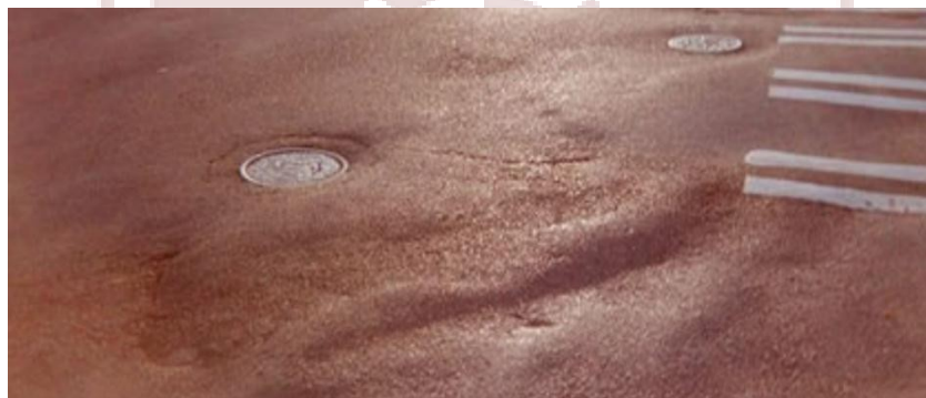
Figura 19: Desplazamiento. Fuente: Corros, Maylin. Urbaez, Ernesto. Corredor, Gustavo (2009)
