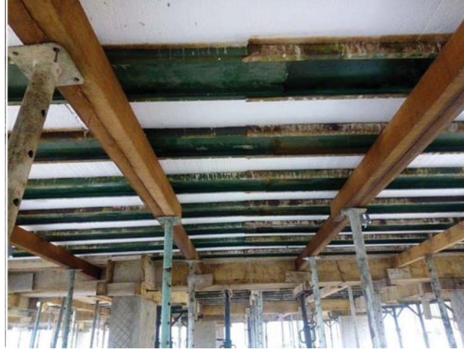
Figura N° 7: Fotografías del encofrado con fenólico - Viguetas
