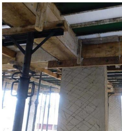
Figura N° 8: Rugosidad de columna.
