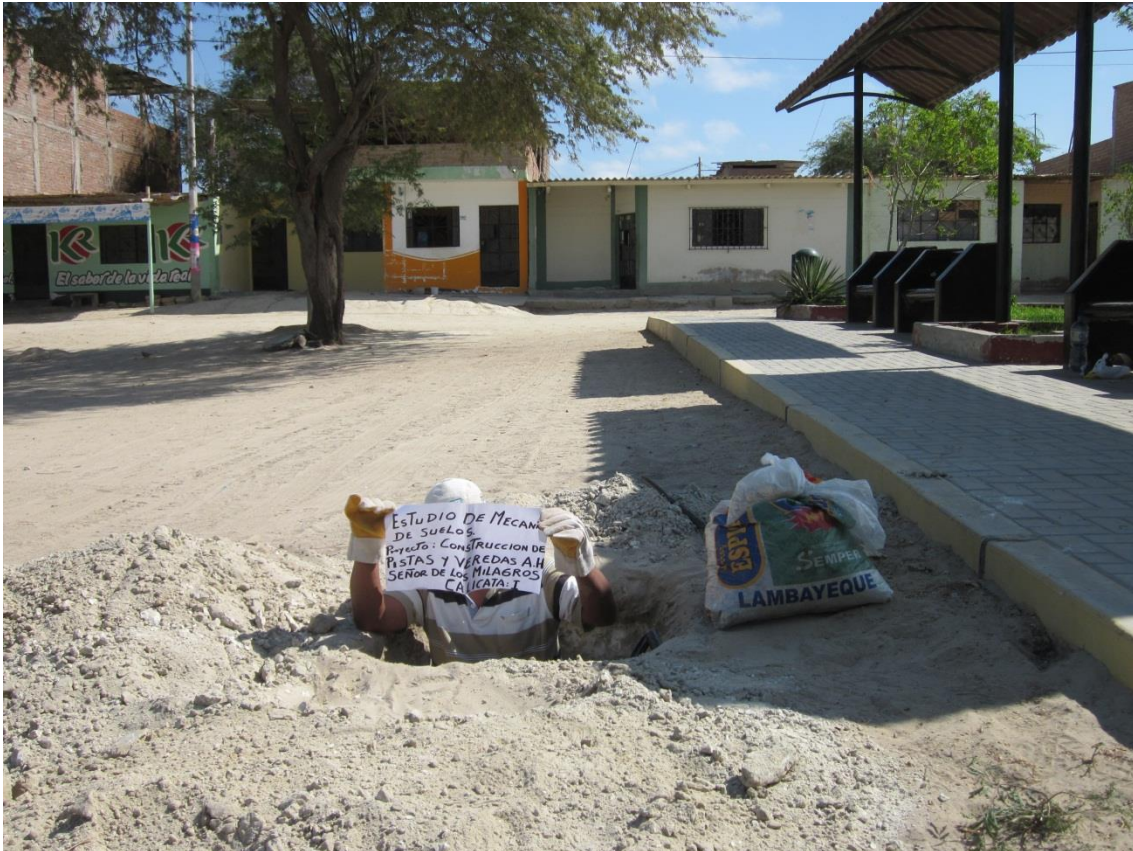
Foto 3: Vista panorámica donde se aprecia el término de la excavación de la calicata C-1
