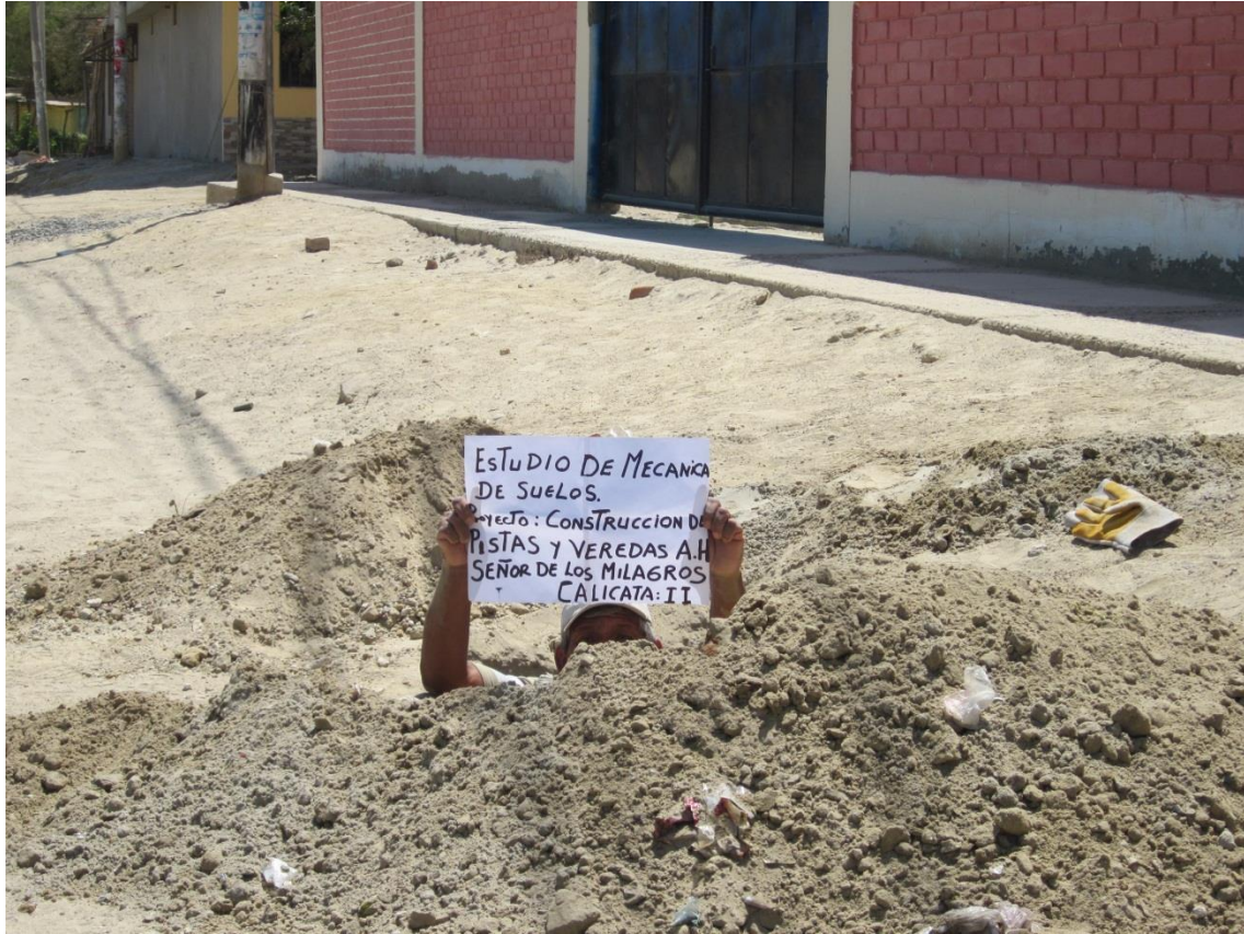
Foto 5: Se aprecia el término de la excavación de la calicata C-2
