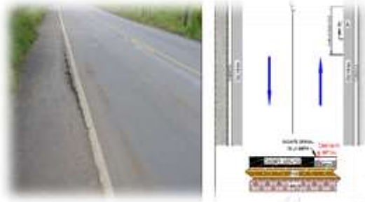
Figura 22: Separación de la Berma
