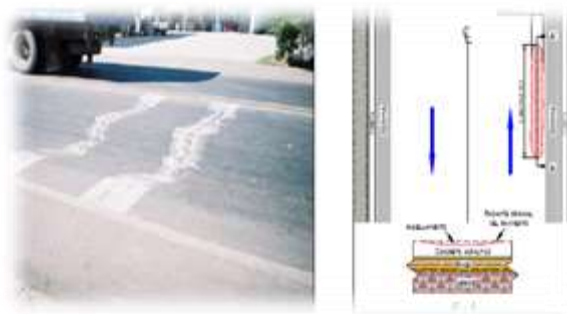
Figura 12: Ahuellamiento
