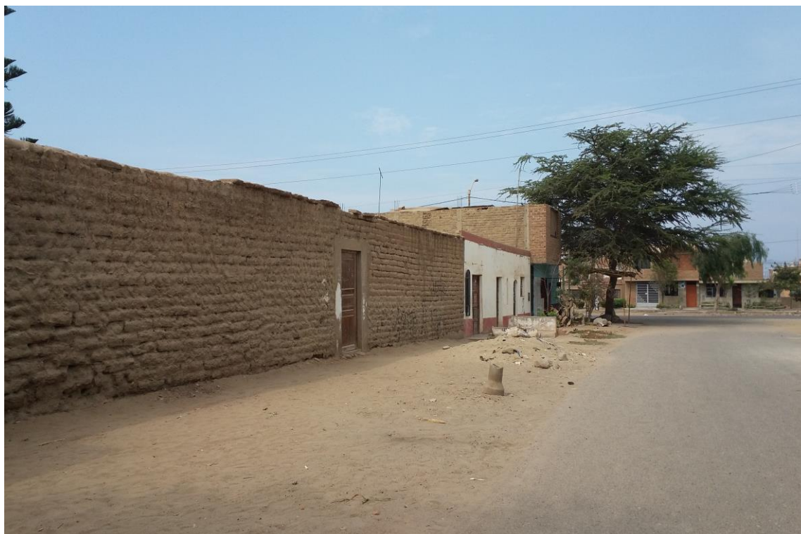
Figura 5: Se aprecia el área compuesto de tierra.
