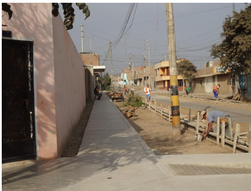
Anexo N° 5: Encofrado de veredas y sardineles
