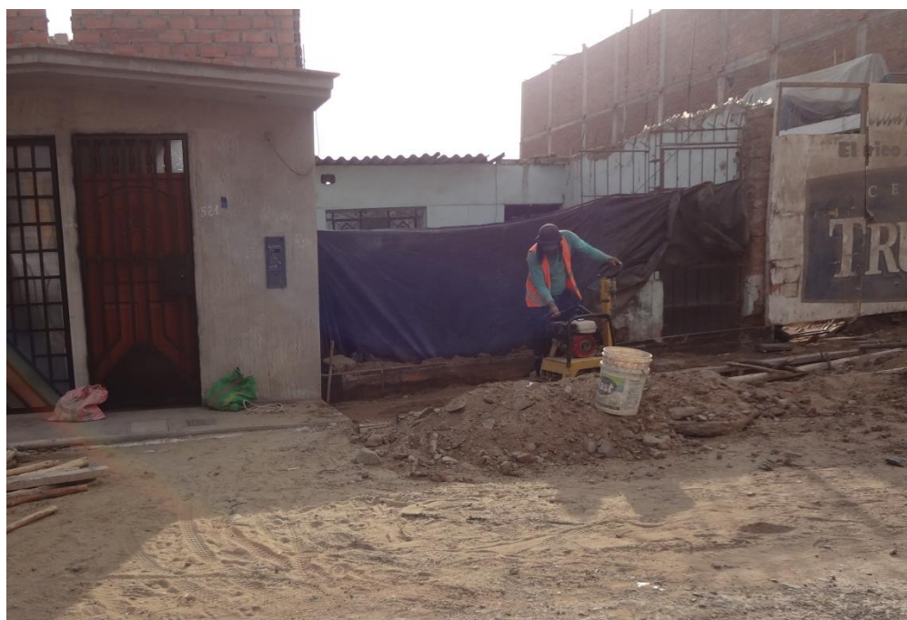
Anexo N° 4: Compactación de la sub rasante
