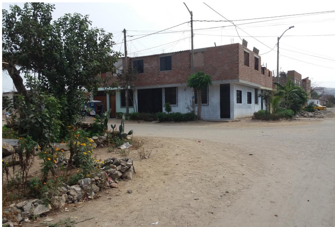
Figura 6: Se aprecia el área compuesta de tierra.
