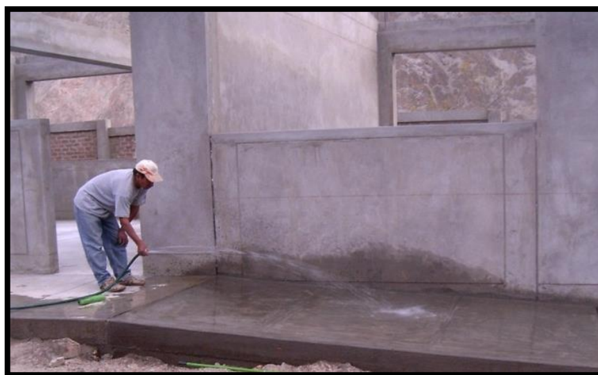
Anexo N°6: Curado De Concreto
