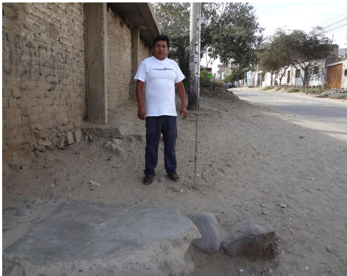
Figura 3: Se puede apreciar el deterioro de un pequeño tramo de vereda hecha por los mismos pobladores, que han tomado en cuenta el estudio técnico.
