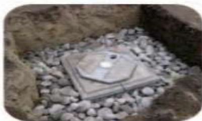
Vertical tipo pozo de absorción.
