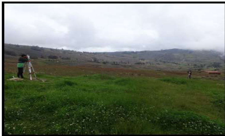
IMAGEN 14: REALIZANDO LEVANTAMIENTO TOPOGRAFICO
