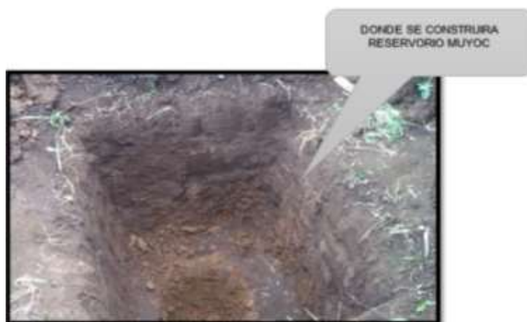
IMAGEN 12: EXCAVACION DE CALICATA
