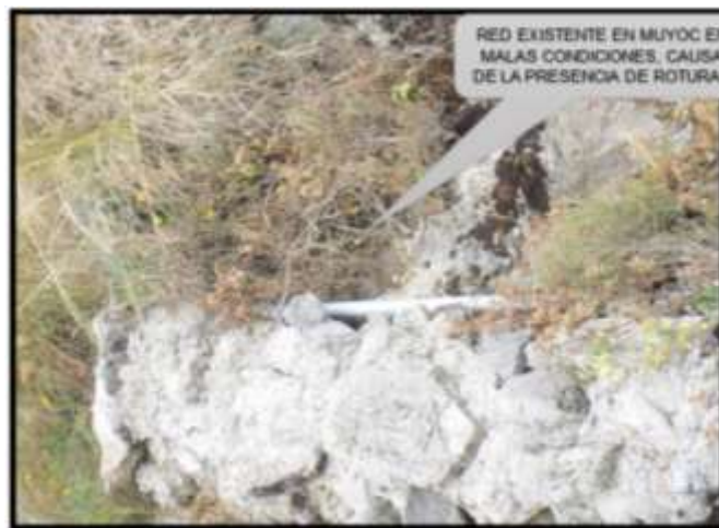
IMAGEN 08: RED DE DISTRIBUCION EN MAL ESTADO MUJOC
