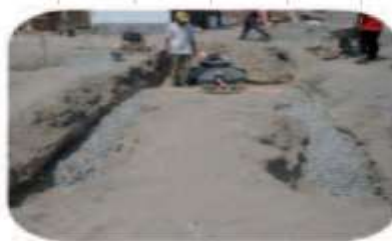
Horizontal tipo zanjas de infiltración.
