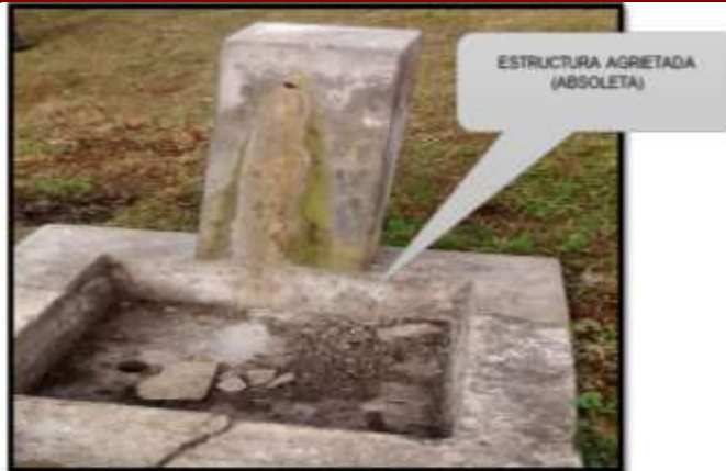
IMAGEN 10: PILETA ABSOLETA MUJOC
