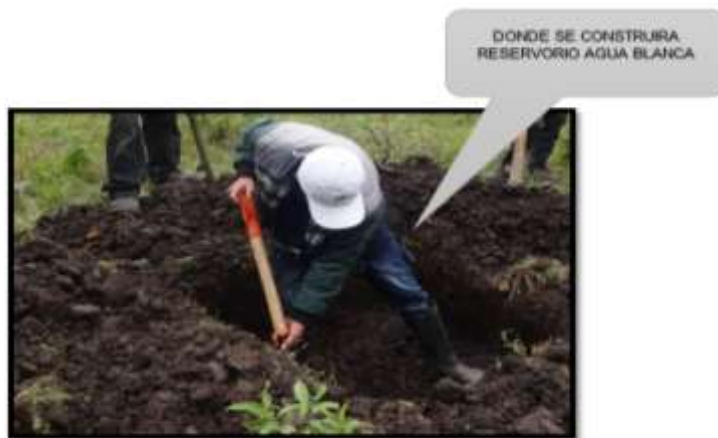
IMAGEN 11: EXCAVACION DE CALICATA
