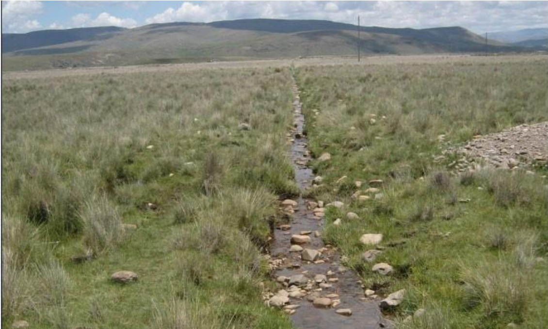
FOTO N°03 SE OBSERVA EL CANAL EXISTENTE EN EL CUAL SE REEMPLAZARA LA RED DE DISTRIBUCION DEL SISTEMA DE RIEGO
