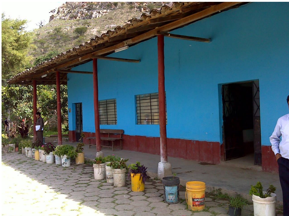
Foto N° 19: Pasadisos de la I.E. Carlos Manuel Cox Rosse - Cholocal, Cajabamba
