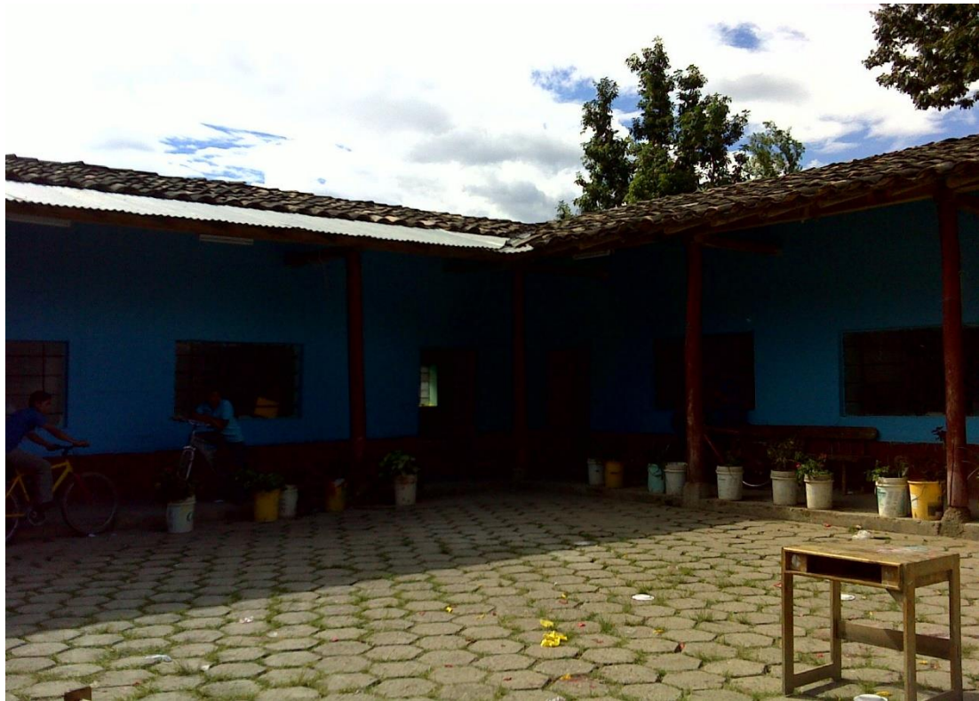
Foto N° 18: Aulas de la I.E. Carlos Manuel Cox Rosse - Cholocal, Cajabamba
