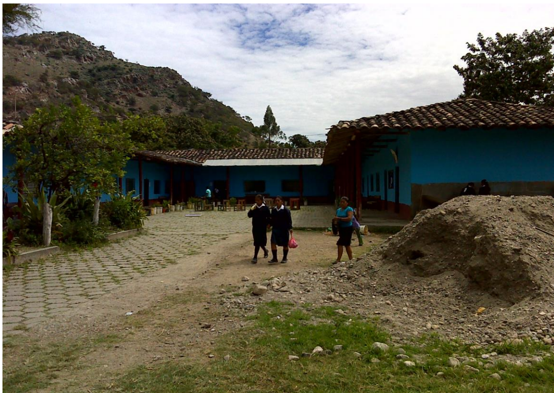
Foto N° 06: Aulas de la I.E. Carlos Manuel Cox Rosse - Cholocal, Cajabamba
