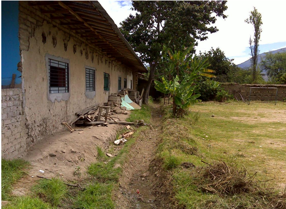
Foto N° 09: Sistema de drenaje de la I.E Carlos Manuel Cox Rosse - Cholocal, Cajabamba
