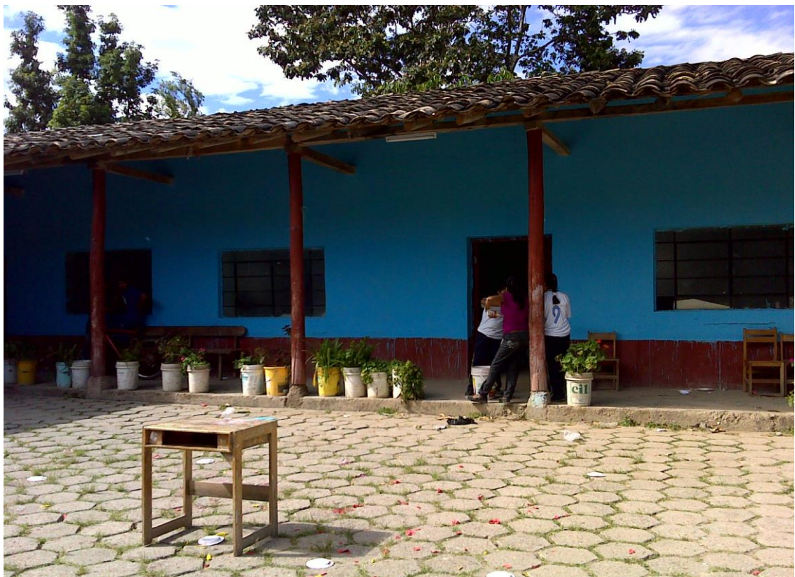
Foto N° 17: Aulas de la I.E. Carlos Manuel Cox Rosse - Cholocal, Cajabamba
