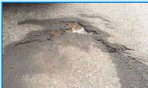
Figura 22 Desplazamiento Fuente (Manual PCI)
