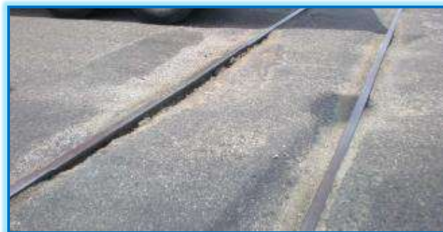
Figura 19: Cruce de vía férrea Fuente (Manual de PCI)
