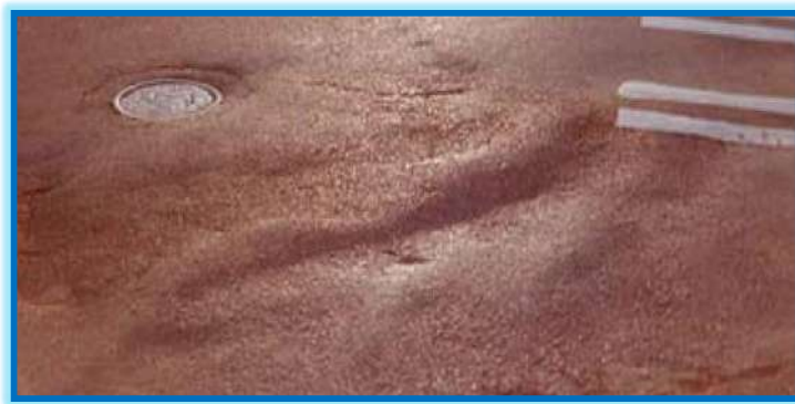
Figura 21 Desplazamiento Fuente (Manual PCI)
