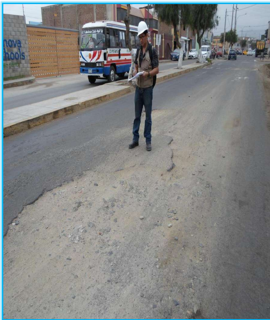
Foto Nº 5 Utilizando la guía de observación para recolectar datos de la vía inspeccionada.
