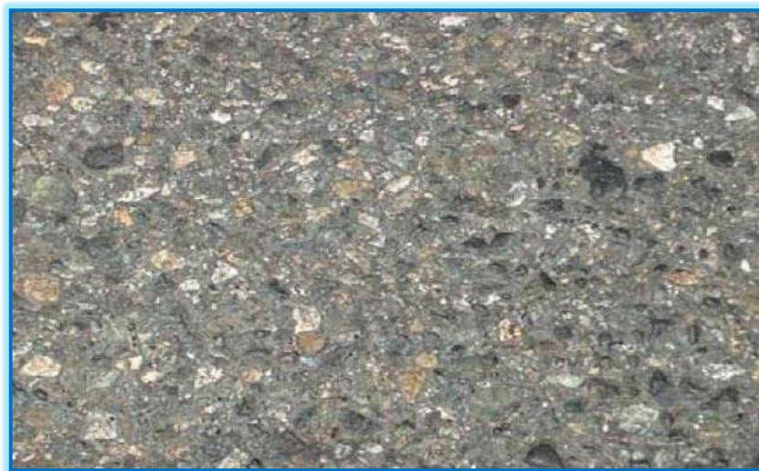
Figura 17: Pulimento de agregados Fuente (Manual PCI)
