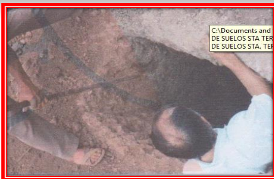
Figura 2: Excavación de calicatas
